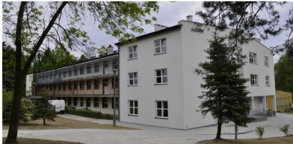
Świeżo dobudowana, południowa część pawilonu Powiatowych Zakładów Opiekuńczo-Leczniczych w Grojcu. Fot. Lech Chodacki
